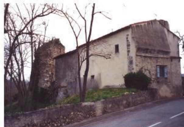
Vestige de la porte de la Trépade, Ouest
