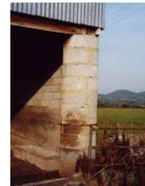
Restitution d'une colonne dans une grange de ferme
