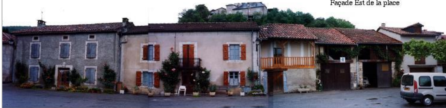
Façade Est de la place
