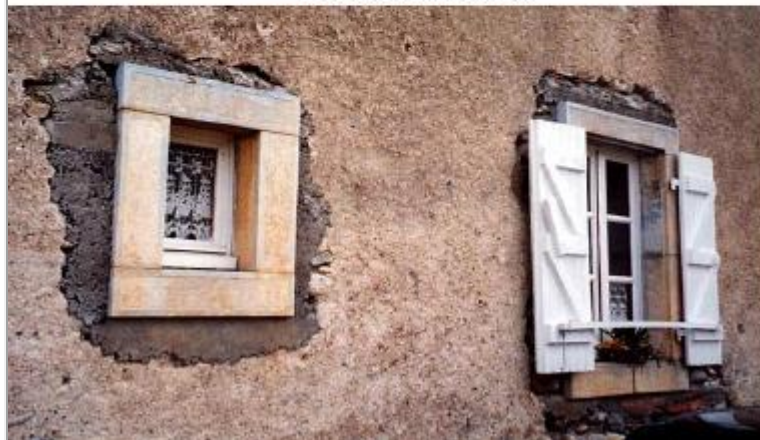
Détails d'ouverture en cours de restauration
