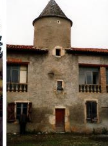
Tour médiévale de la maison Bordère
